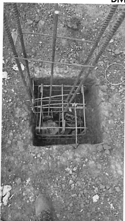
Figura 6 – Bloco de coroamento com estaca fora do centro do eixo da estaca e a armadura do pilar descentralizado.
