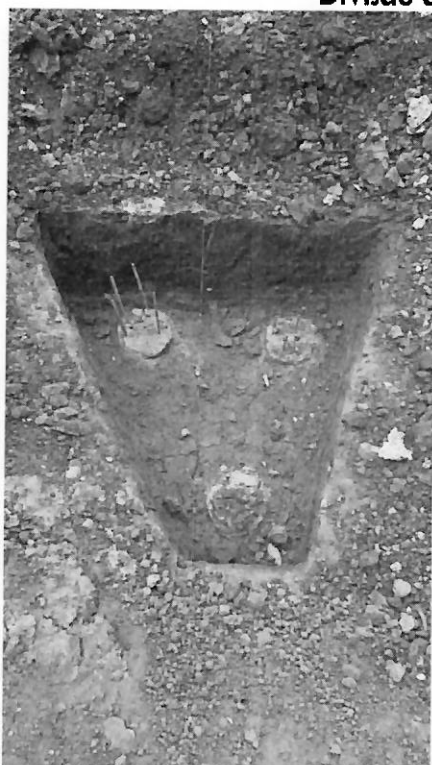
Figura 1 – Bloco de coroamento de três estacas fora das medidas do projeto e com alterações no posicionamento das estacas. Bloco do pilar P9
