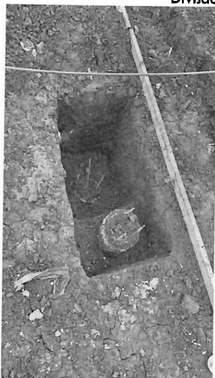
Figura 4 - Bloco de coroamento de duas estacas com o corte das estacas executado em níveis muito diferentes. Bloco de coroamento do pilar P3 ao lado do bloco de coroamento de três estacas da Biblioteca.
