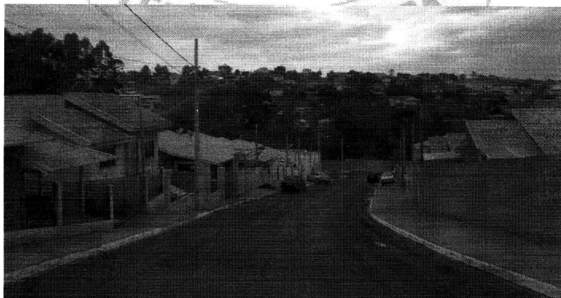
Rua Projetada nº 01 -> Rua Orquídea
