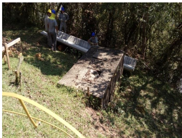
Figura 53: Início do trecho 2 da adução de água bruta.
