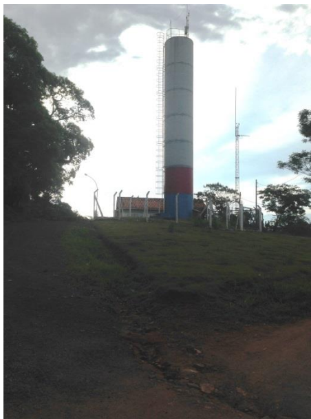
Figura 67: Reservatório Apoiado da Vila Rural.
