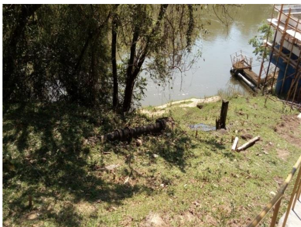
Figura 52: Primeiro trecho da adutora de água bruta.
