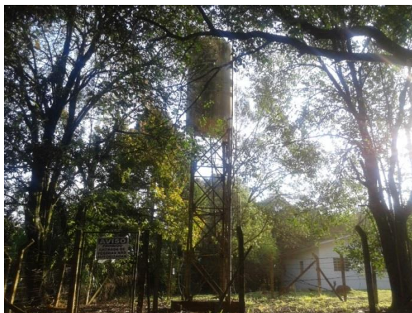
Figura 60: Reservatório Elevado (REL-03) – Triângulo.
