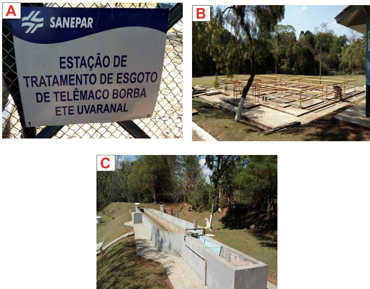
Figura 79: ETE Uvaranal detalhe da sinalização (A); vista geral (B); desarenador (C).
