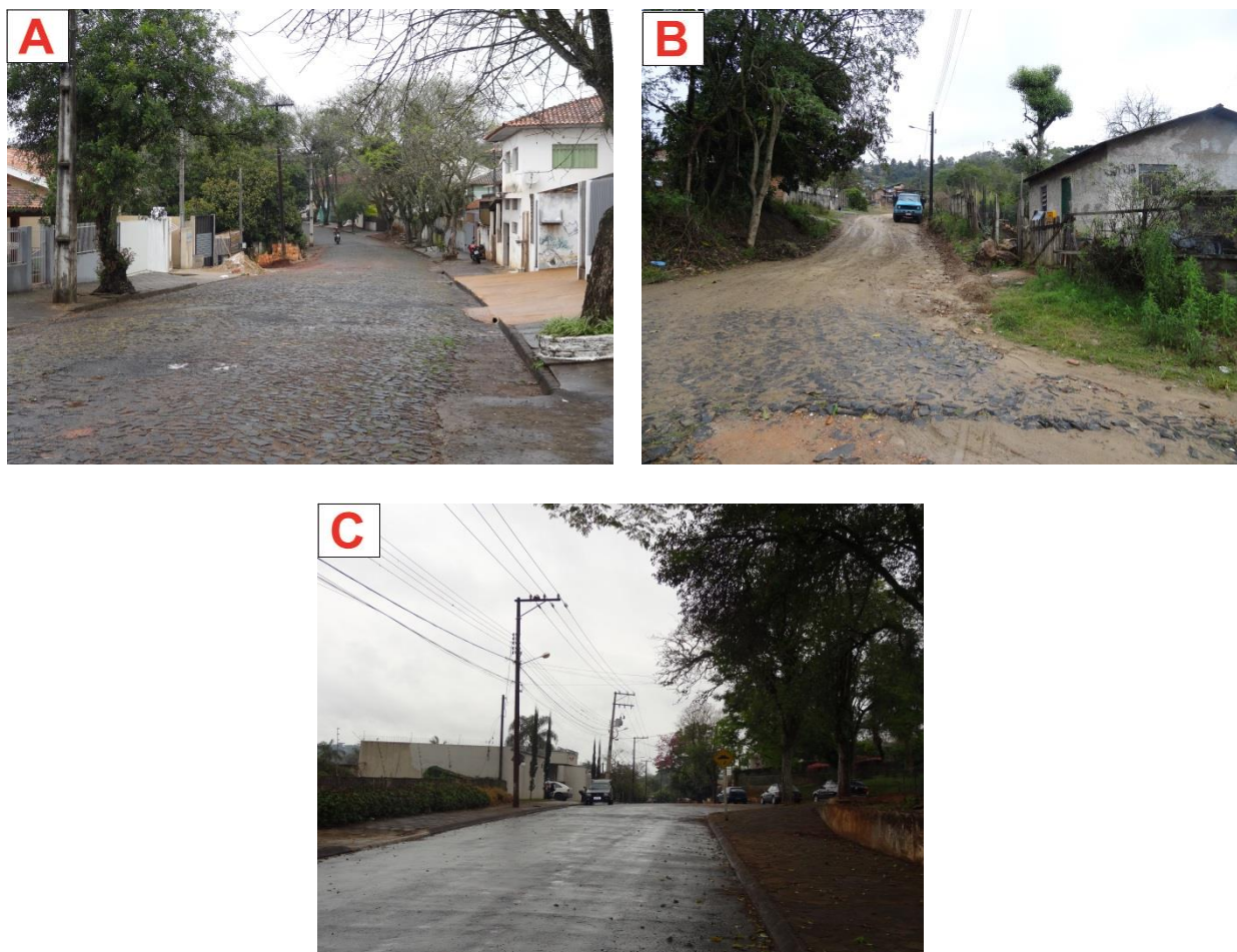
Figura 90: Tipos de pavimento em Telêmaco Borba - Poliédrico (A); Cascalho (B); Asfalto (C).
