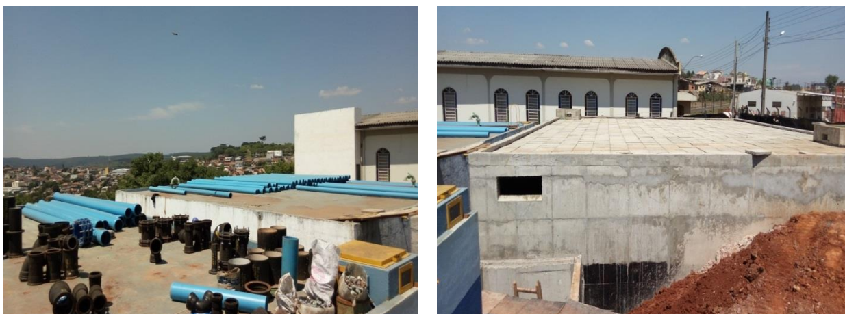
Figura 59: Reservatório Campina Alta.
