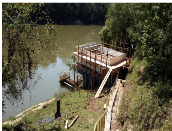
Figura 51: Local de captação superficial no Rio Tibagi.
