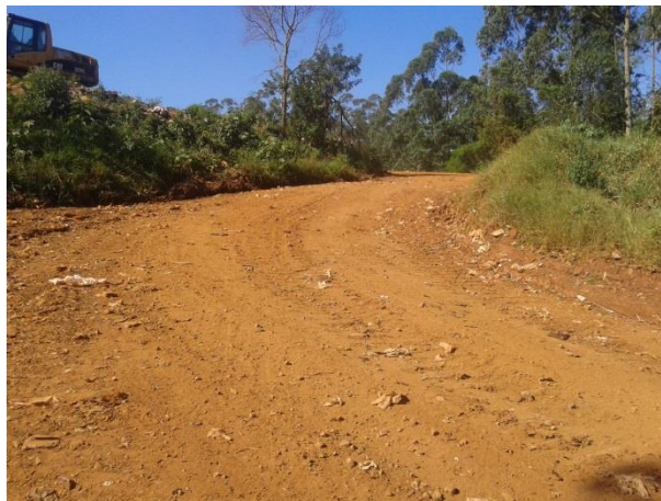
Figura 143: Estrada de acesso interno ao aterro sanitário.
