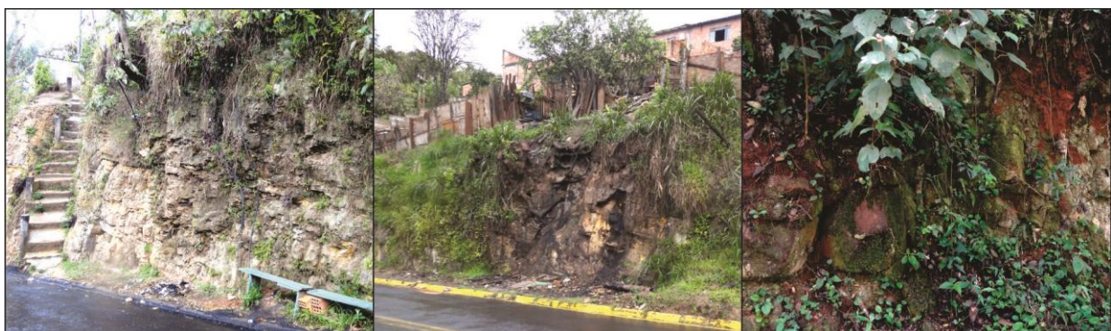
Figura 14: Afloramento de rochas na entrada do Bairro Vila Esperança.
