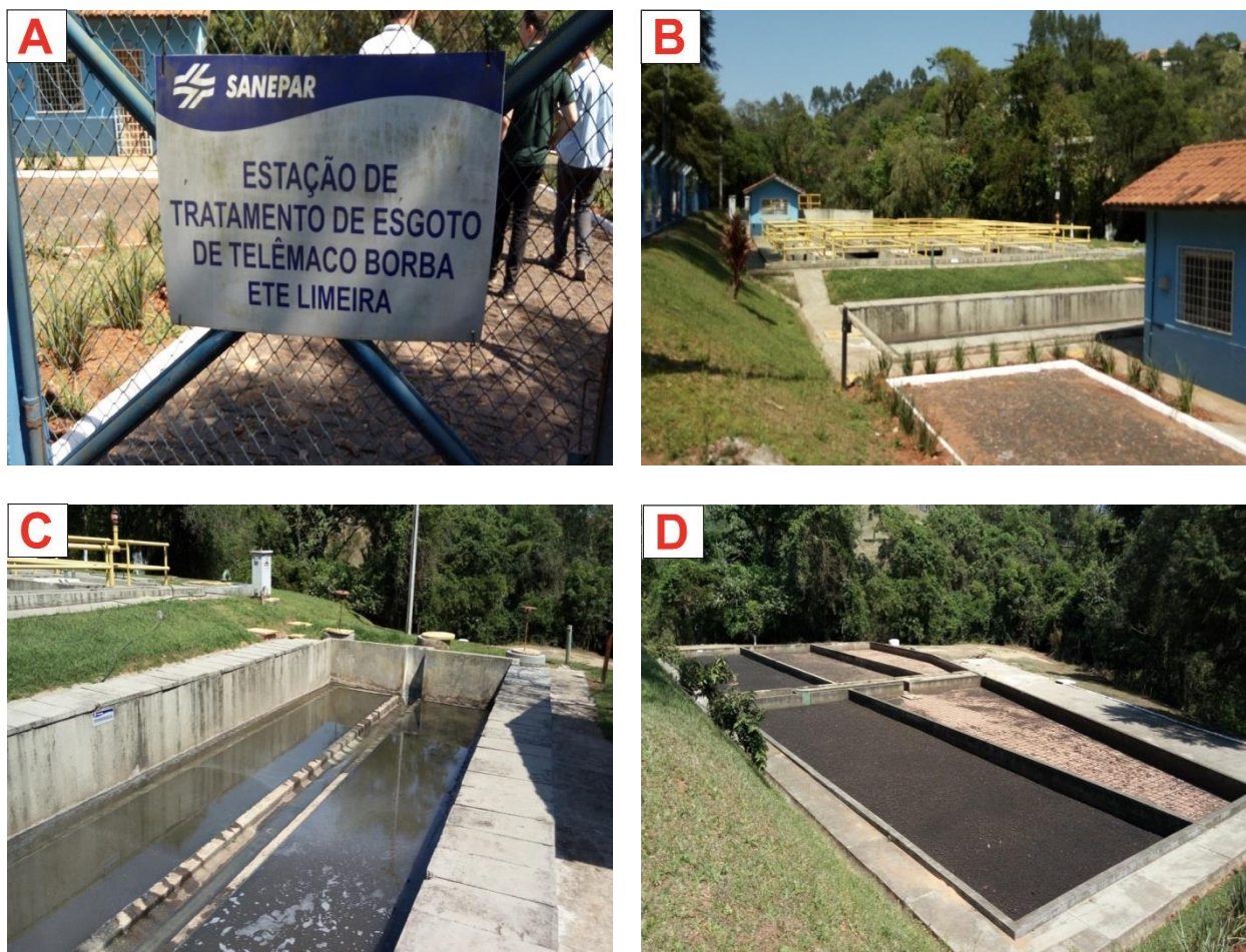
Figura 78: ETE Limeira - Detalhe da sinalização (A), vista geral (B), sedimentador (C) e leito de secagem (D).
