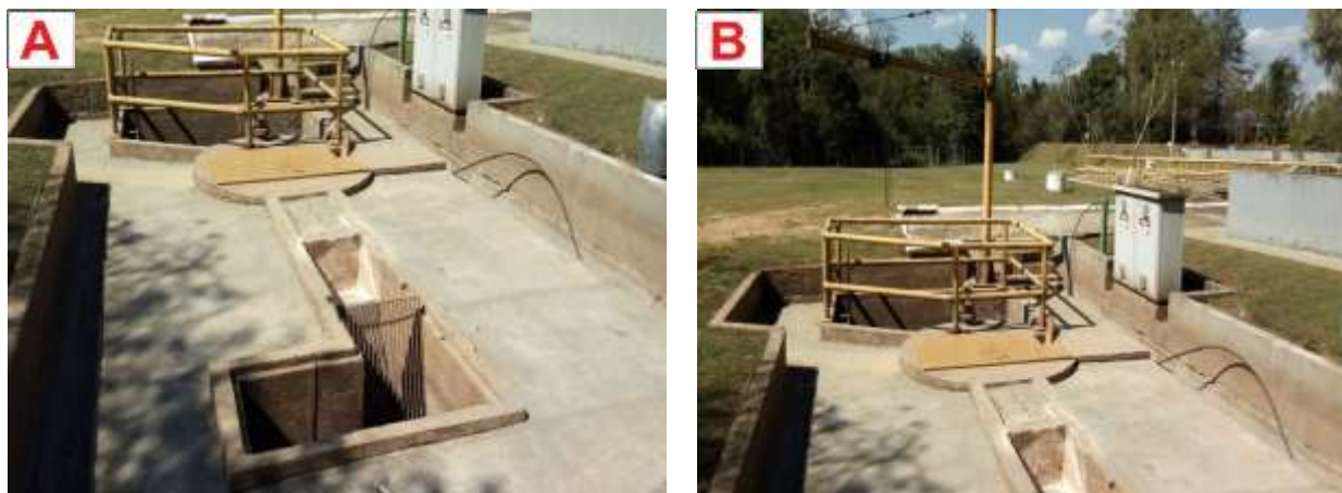
Figura 80: ETE Uvanaral, gradeamento (A); vista geral (B).
