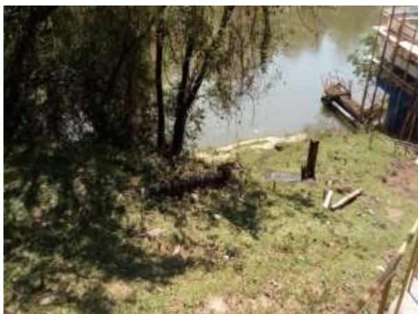
Figura 52: Primeiro trecho da adutora de água bruta.
