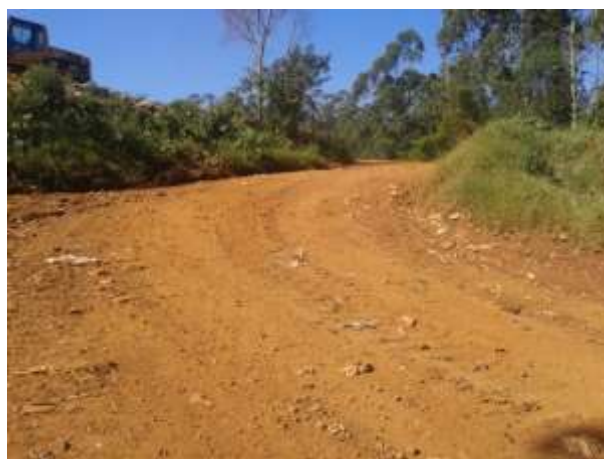
Figura 143: Estrada de acesso interno ao aterro sanitário.
