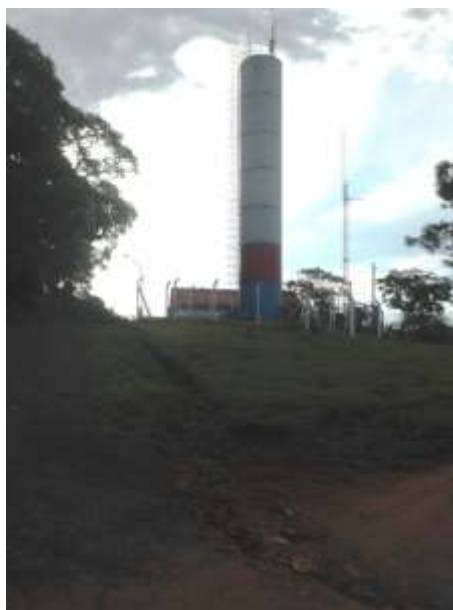
Figura 67: Reservatório Apoiado da Vila Rural.
