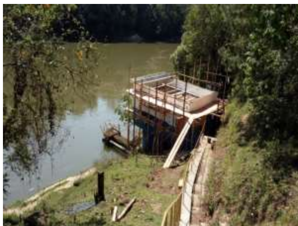
Figura 51: Local de captação superficial no Rio Tibagi.
