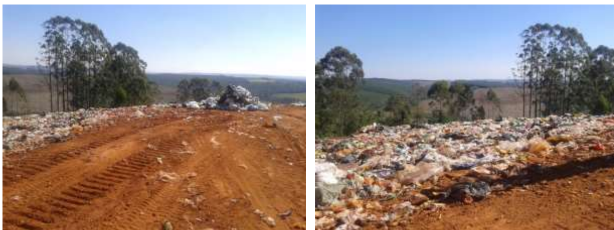
Figura 141: Disposição dos resíduos no aterro sanitário.
