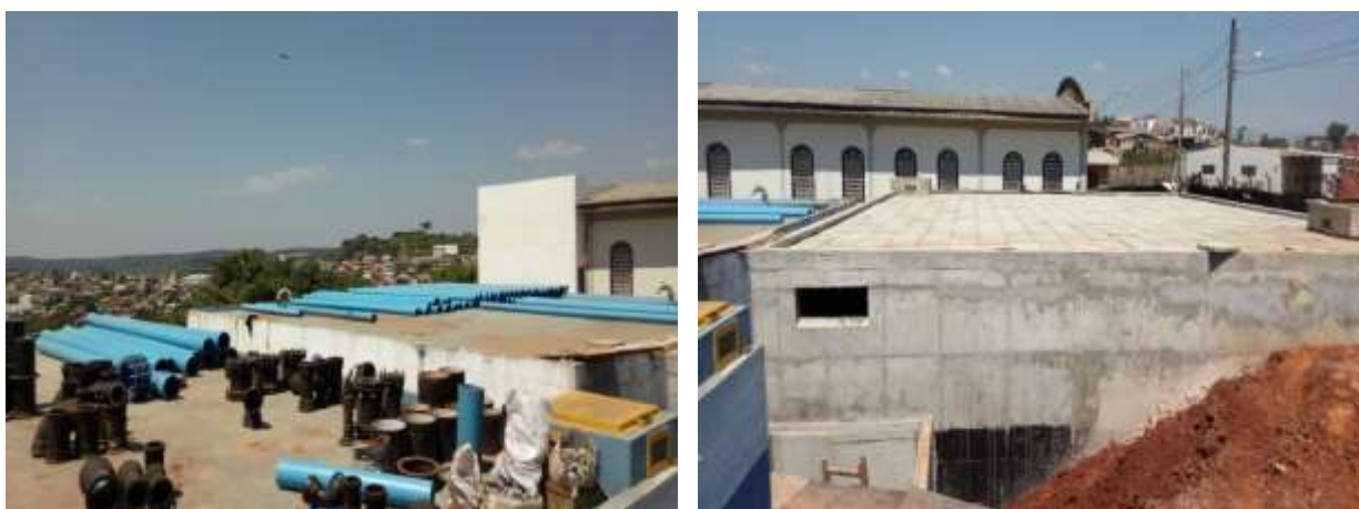
Figura 59: Reservatório Campina Alta.
