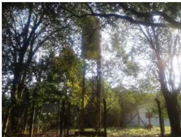
Figura 60: Reservatório Elevado (REL-03) – Triângulo.
