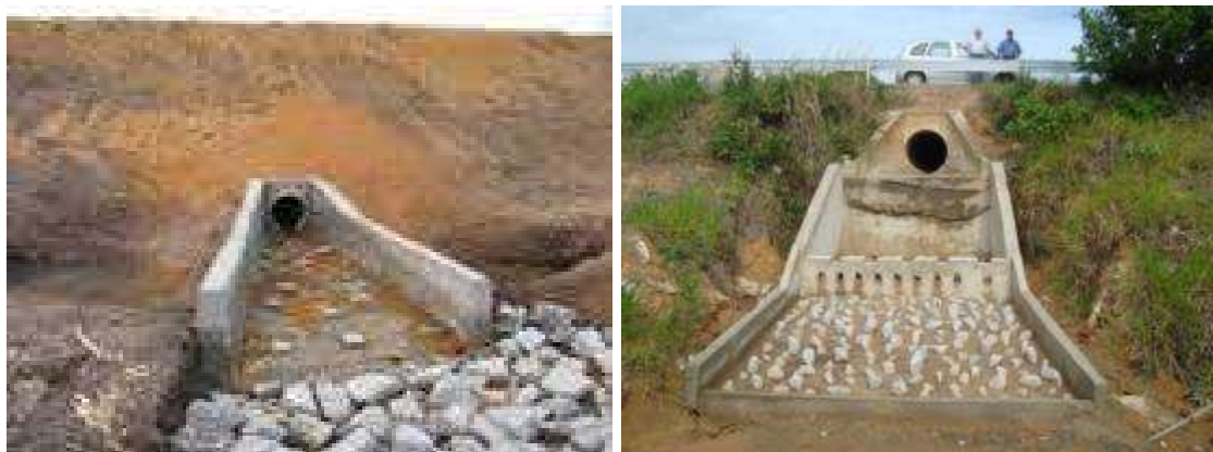
Figura 162: Dissipador de Energia em Caixa
